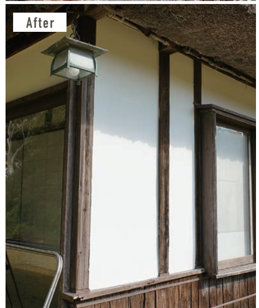
特に傷みの酷かった壁は下地から補修し、凹凸の激しい面は二度塗りで表面を調節するなど、「ただ塗る」のではなく、美しく整え、仕上げました。
