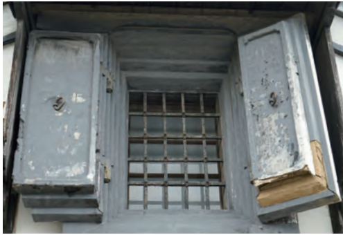
塗料が剥がれ、角の欠けた部分も見られます。
