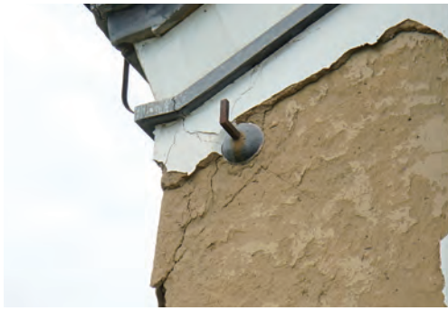
露出した土壁は見栄えはもちろん強度の低下にも。
