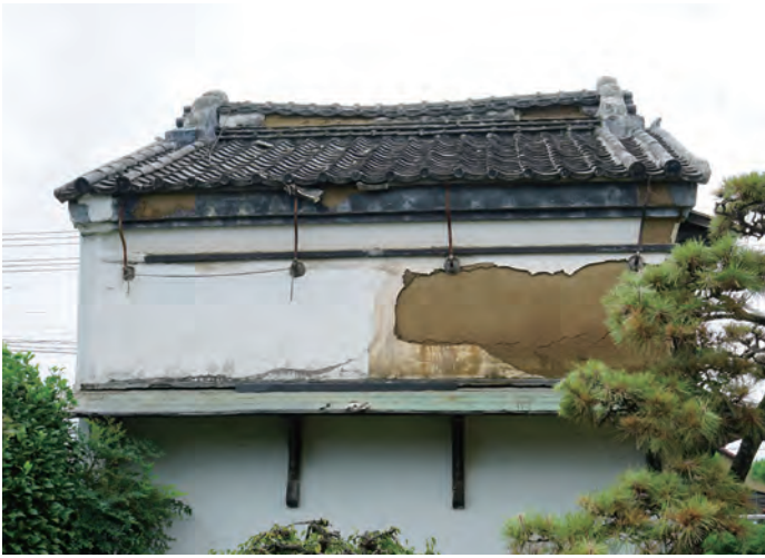
壁の左側にはお父様がDIYで補修をした跡が。
