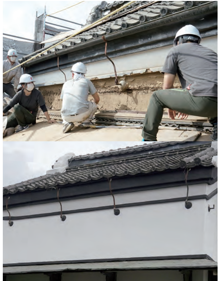
劣化した壁は全て剥がし、下地から作り直し。完全に欠損した部分は、モルタルで形を再現しました。
