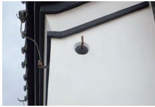
下地を自社プライマーで強化し漆喰で平滑に。
