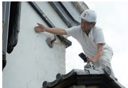
目に見えない剥離がないか状態を確認。
