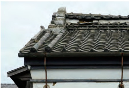
風雨や地震に耐えた棟。
